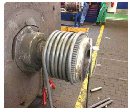
Nagrzewanie połączeń Montaż i demontaż
